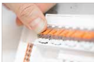
Verrouiller la borne dans le support
