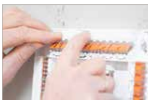
Positionner le marquage dans le support
