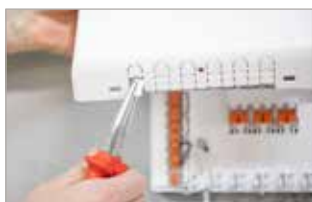
Enlever l'opercule du couvercle
